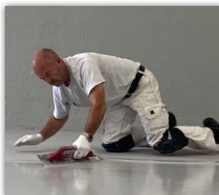
Auftragen der Deckbeschichtung mittels Traufel.
