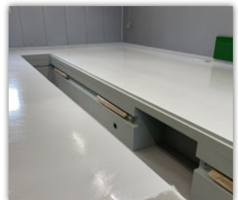
Fertige Bodenbeschichtung mit Zusatz und Absanden mittels Quarzsand.
